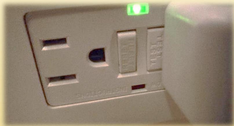
插座型漏電斷路器
