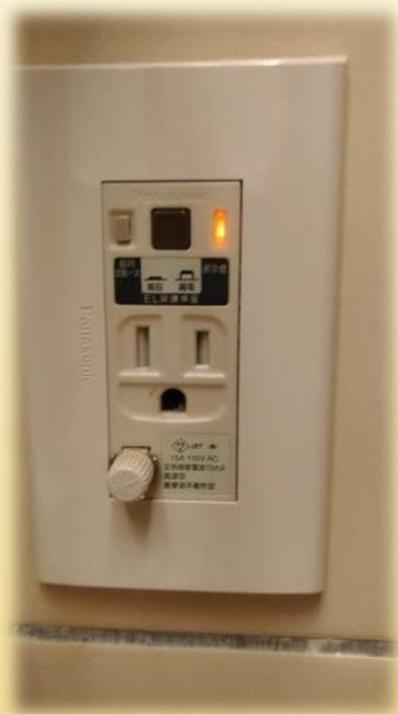
插座型漏電斷路器
